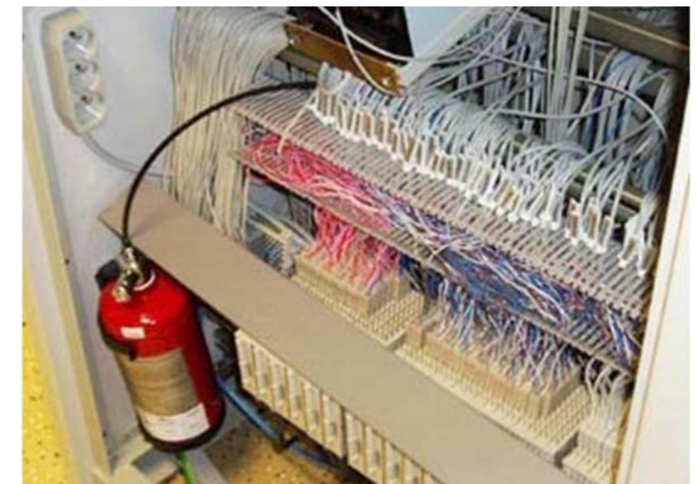
Рис. 2. Модуль АУП-01Ф, размещенный внутри защищаемого объема
