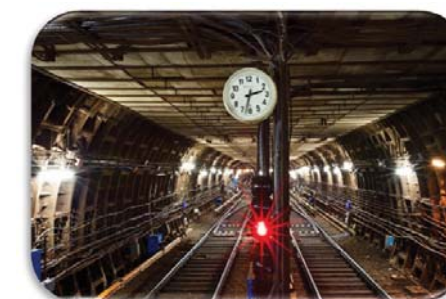
Рисунки 4, 5. Двухпутный тоннель в Москве
